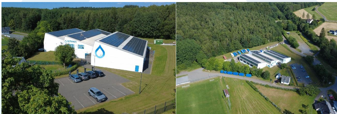
Abbildung 10: Standort Üttfeld Quelle: (Zahnen Technik GmbH)
