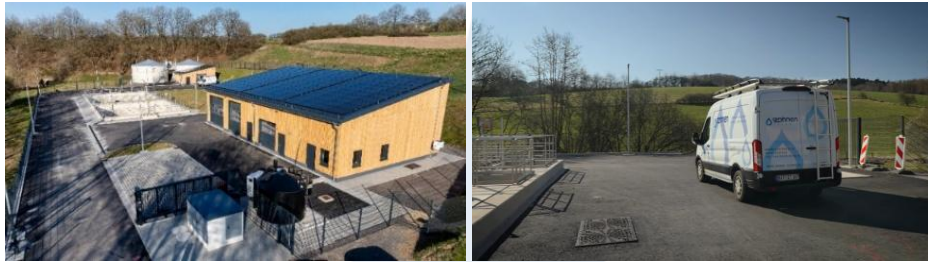
Abbildung 4: Arbeiten auf der Kläranlage in Arzfeld Quelle: (Lucas Zimmermann LMZ Media )
