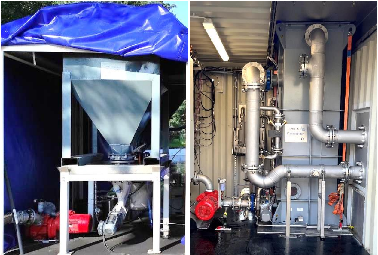
Abbildung 4-5: Fotos der Pilotanlage auf der KA Speyer; links: PAK-Dosierung; rechts: Flexbed Filter (beide Fotos zur Verfügung gestellt von Zahnen)
