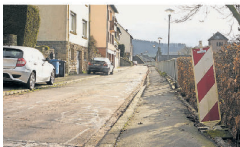
Am Annenberg in Kyllburg laufen Bauarbeiten, die rund acht Monate dauern sollen.
