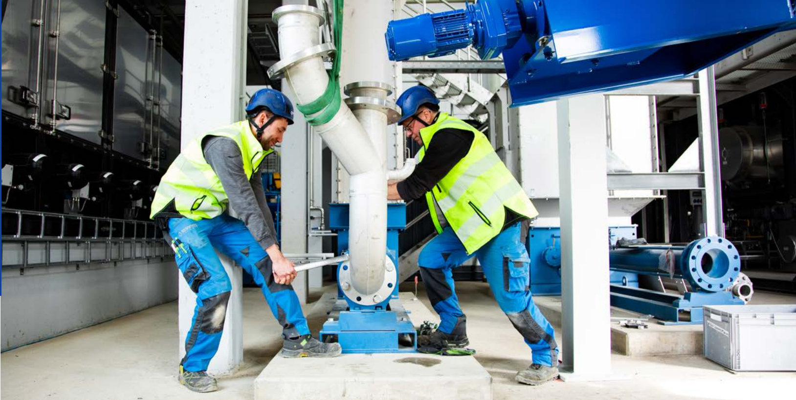
Arbeiten auf einer Baustelle.
